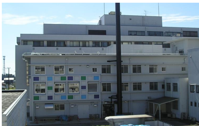
写真2 改修後北面外観
