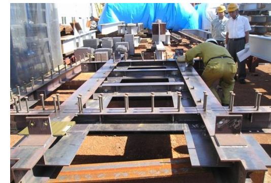
写真4 鉄骨補強部材製作状況
