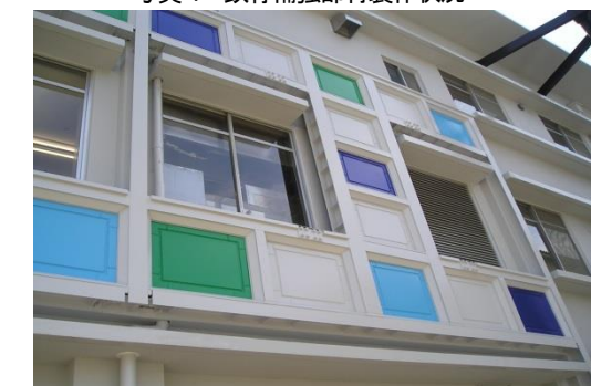
写真5 北面外部鉄骨補強
