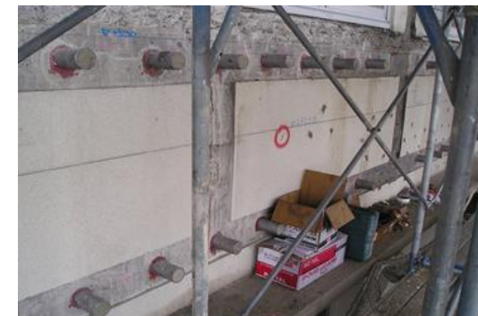
写真3 北面外部補強接合部（鋼管コッター）
